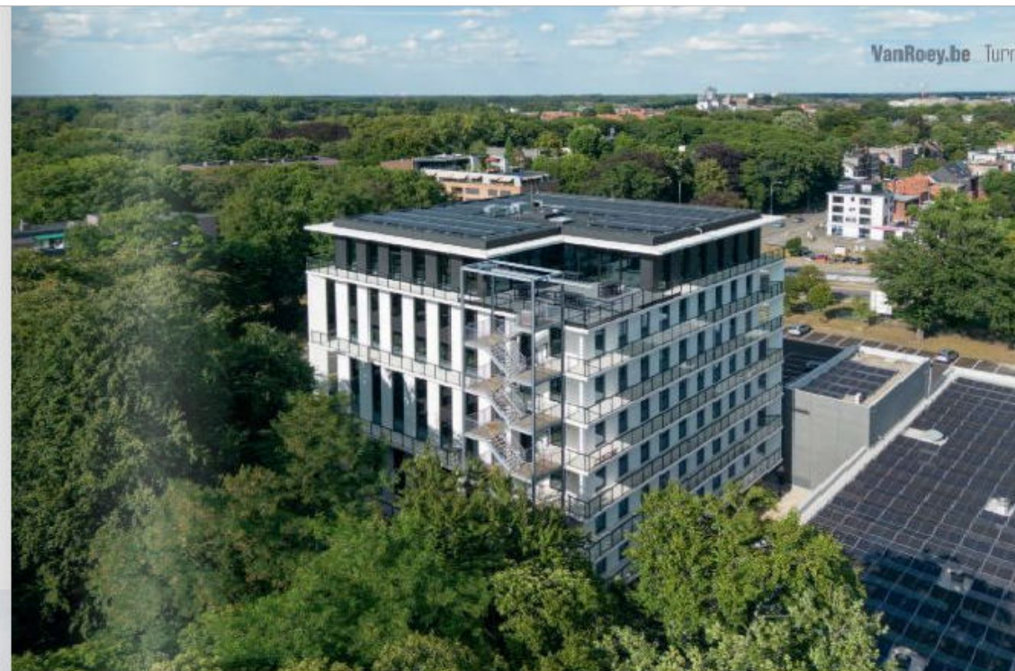
Zuidwestgeoriënteerde hoek met vluchttrap op de zevende verdieping. 360 PV-panelen maken het gebouw regenogst het hele jaar door energieneutraal.
